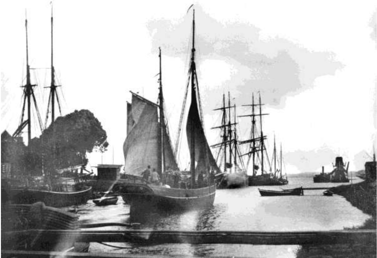
Abb.: 9. Ausfahrt des Eiderkanals in Holtenau um 1890
