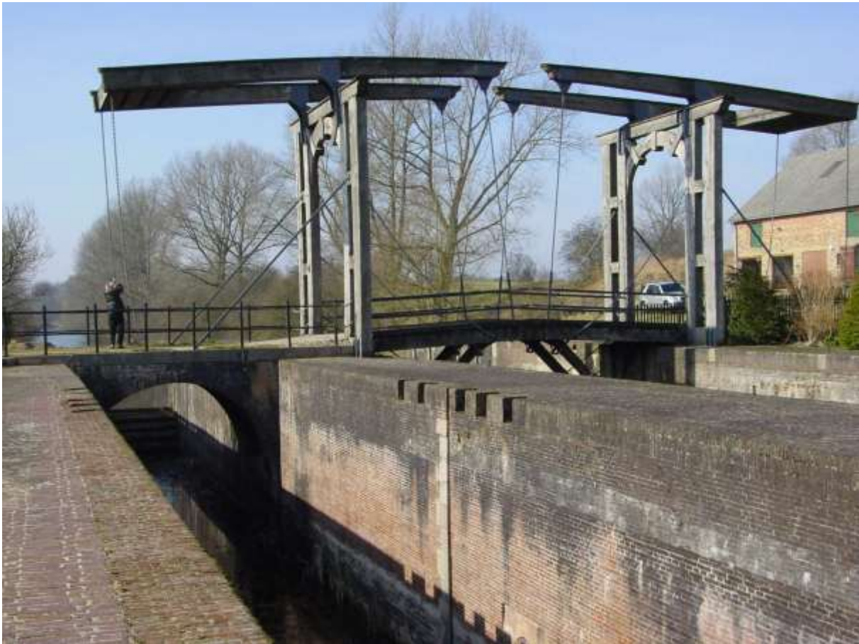
Abb.: 5. Restaurierte Schleuse Klein Königsförde
